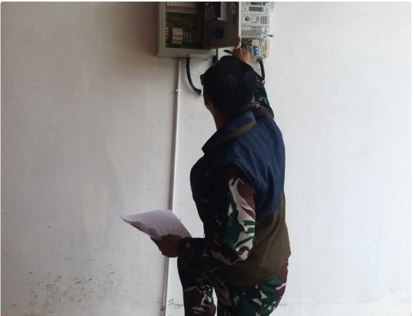
Pengevekan instalasi listrik KDKMP Desa Mekarjaya
